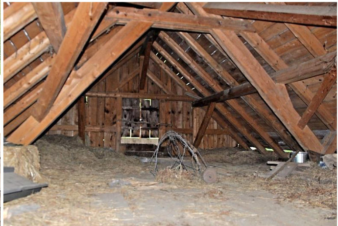
Lageraum OG (ehem. Heustock)
