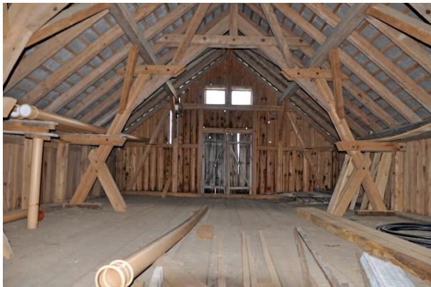
Lageraum OG (ehem. Heustock)
