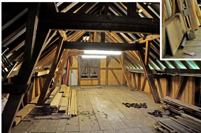
Lageraum OG (ehem. Heustock)
